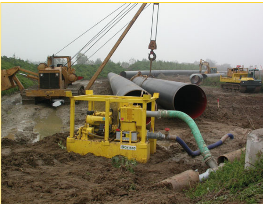
Drenaggio scavi per posa metanodotto Drainage excavation for pipeline installation Drenaje de las excavaciones para puesta metanoducto
