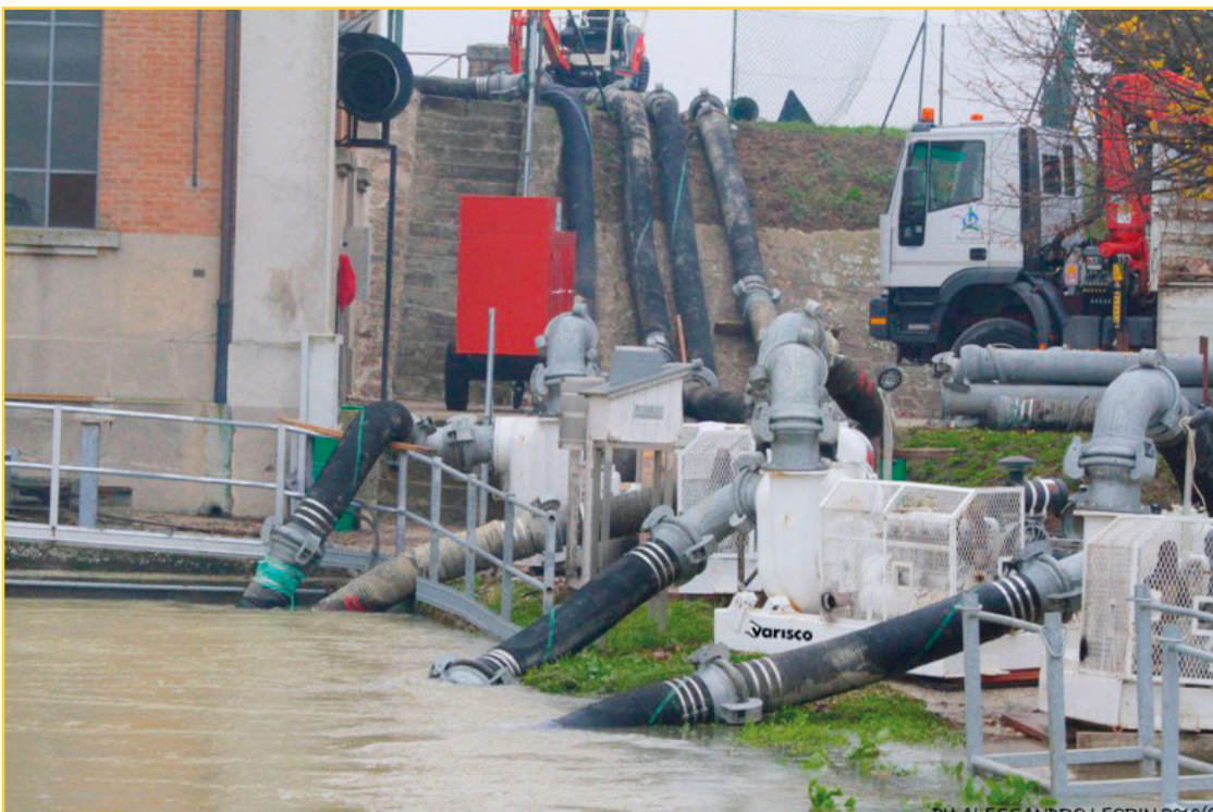
Drenaggio di zona allagata Drainage of flooded area Drenaje de lugar inundado
